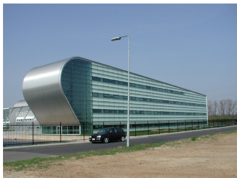
FIGUUR 10: SCHEMA OPEN-GESLOTEN GEVELS: VOOR KANTOORGEBOUWEN GELDT DAT GEVELPARTIJEN ALTIJD VOLWAARDIGE PARTIJEN MOETEN ZIJN. DUS OPEN OF GESLOTEN EN ALTIJD OVER DE VOLLEDIGE HOOGTE VAN MINSTENS ÉÉN BOUWLAAG.
