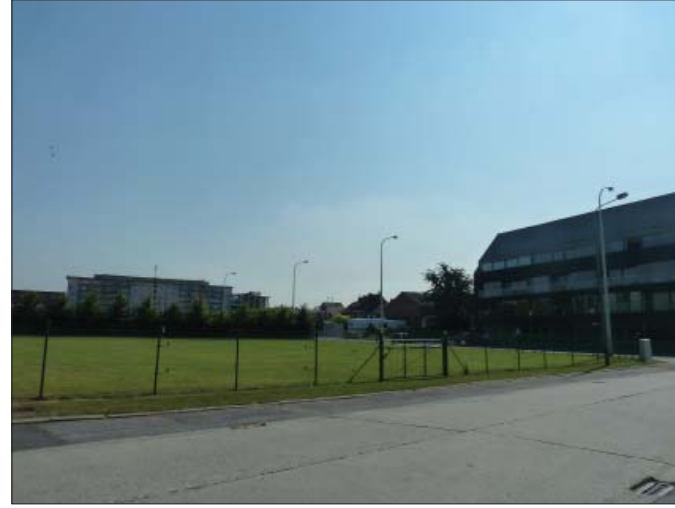
BROELSTRAAT – ZICHT OP HET NIEUWE APPARTEMENTSGEBOUW EN HET CENTRUM VAN HARELBEKE
