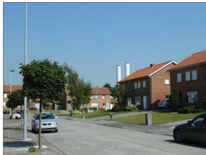
SALVIASTRAAT – ZICHT RICHTING HET BEDRIJVENTERREIN VAARNEWIJK EN DE SCOUWEN VAN INFRAX
