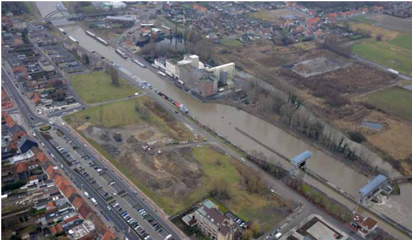
Sluiscomplex en de gronden van Westwijk
