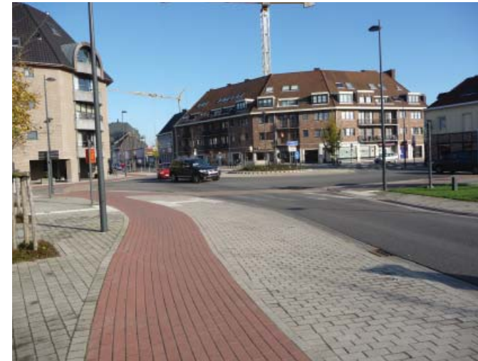
Ook de andere hoek naar de Marktstraat wordt vormgegeven met een appartementsgebouw van 4 bouwlagen hoog.
