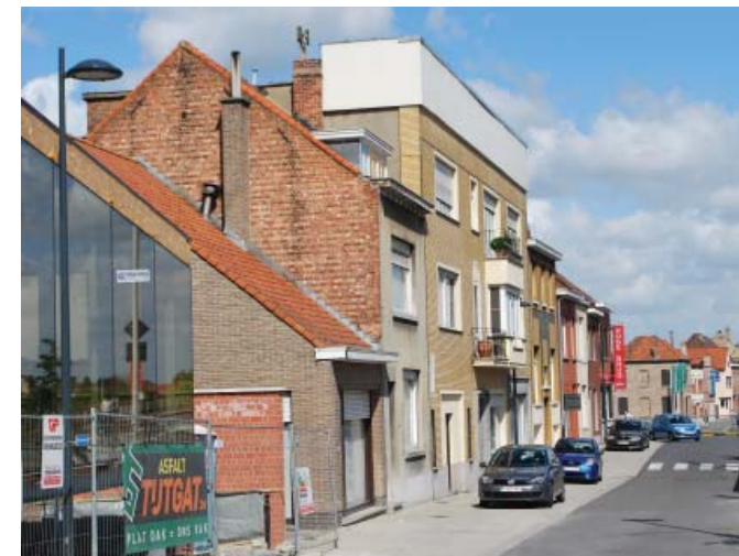
De Leiestraat wordt gekenmerkt door woningen in rijbebouwing met een hoogte variërend van 1 tot 3 bouwlagen.
