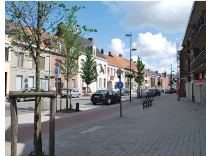
De Marktstraat (N43) werd recent heringericht met brede voetpaden, fietspaden, parkeerstroken en bomenrijen langs beide zijden van de weg.
