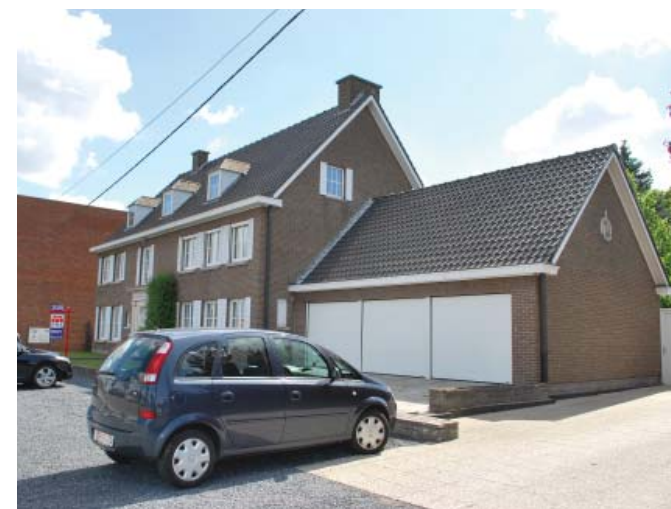
De villa langs de Twee-bruggenstraat is eveneens twee bouwlagen hoog en heeft een dakverdieping.
