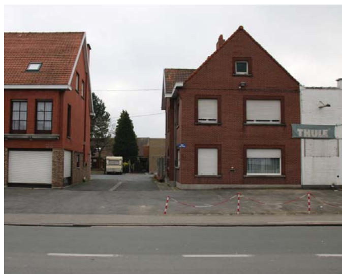
HUIS AAN OVERLEIESTRAAT EN DOORGANG NAAR CLUSTER
