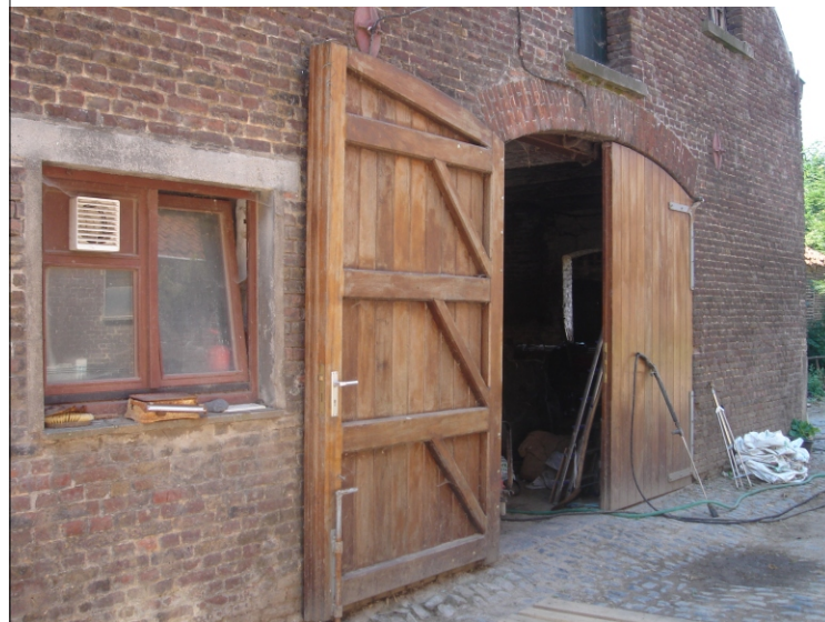
Bepaalde delen van de westelijke vleugel van de hoeve zijn gerestaureerd, zoals bovenstaande poort.
