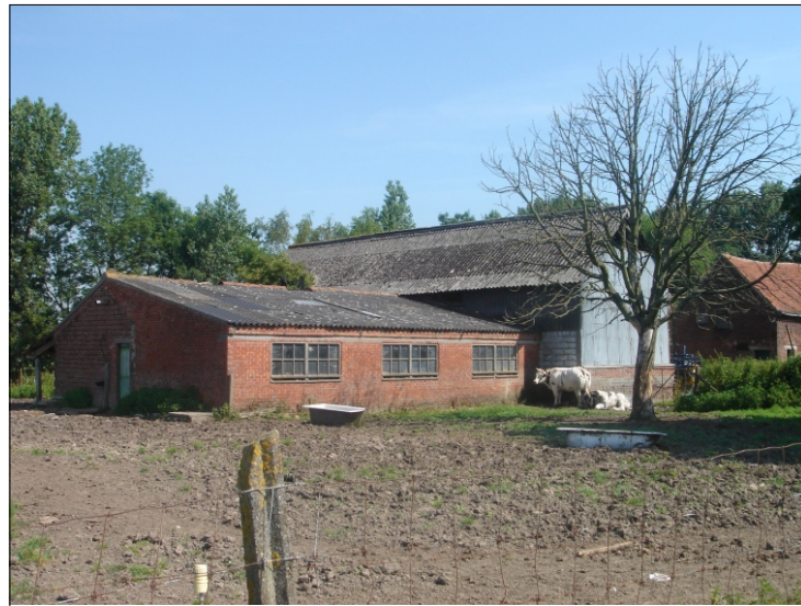
De bebouwing rond de historische hoeve wordt gekenmerkt door een verscheidenheid in stijlen. Hierboven het lokaal voor groentenverwerking in baksteen en een berging in golfplaten en baksteen.
