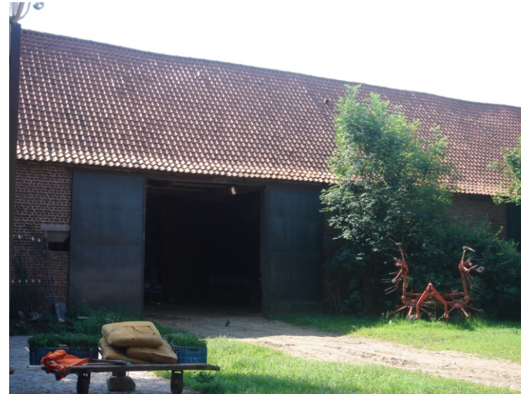
De zuidelijke vleugel van de hoeve is nog in vrij goede staat. Groen langs de gevel verstopt het gebouw.
