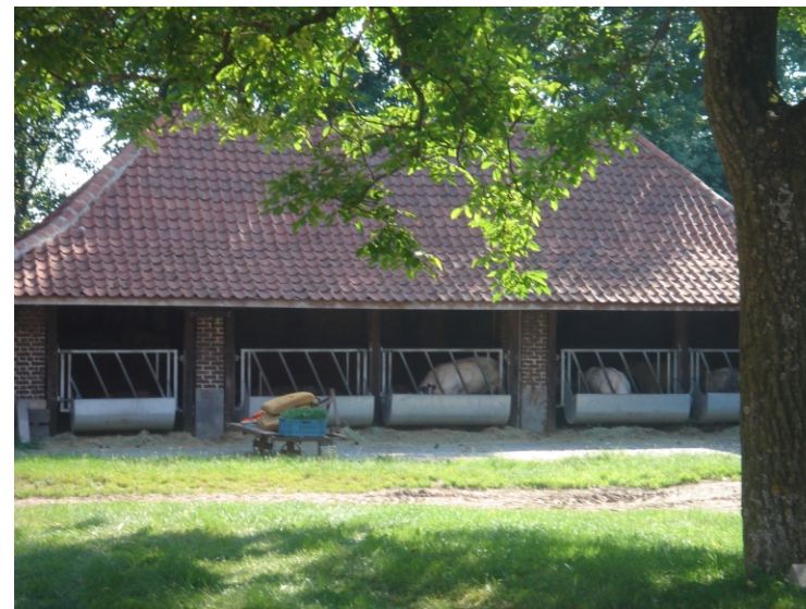
De oostelijke vleugel van de hoeve is de kleinste vleugel. Dit gebouw is volledig gerestaureerd.
