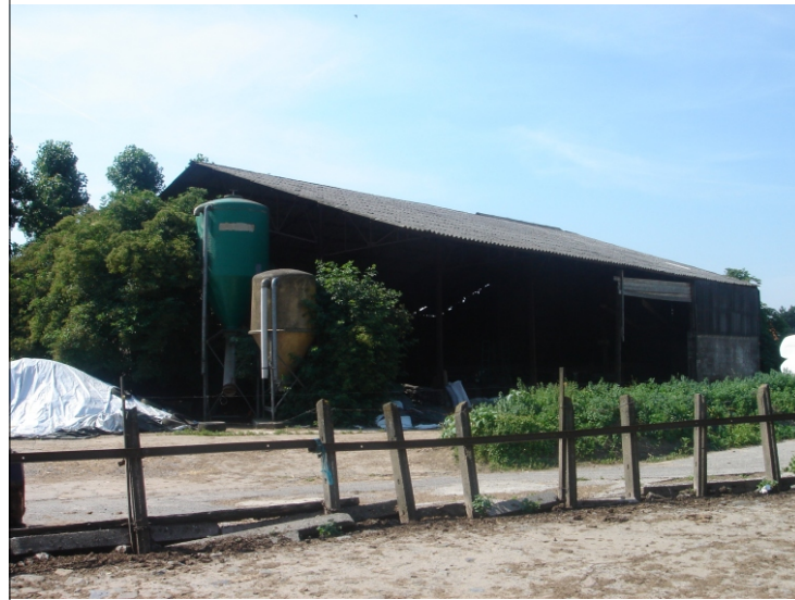
Achteraan op het perceel staat een open loods, voor de opslag van hooi en stro. De loods bestaat uit golfplaten.
