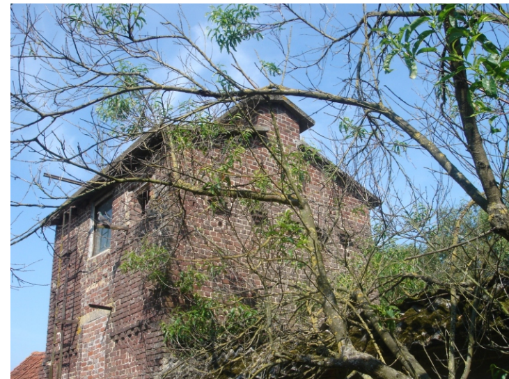
Achter het woonhuis staat een oude chicorei -ast. Dit gebouw werd vele malen verbouwd, en is momenteel niet in gebruik.
